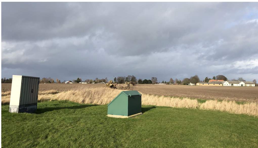
Figur 1: Eksisterende indvindingsboring hos Strøby Ladeplads Vandværk
